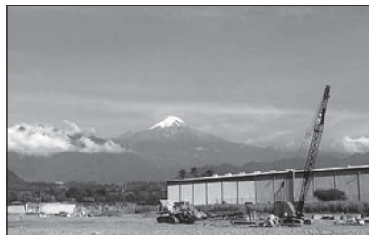
Экскаваторные работы на площадке компании Tuasa при строительстве комбинированной линии цинкования и нанесения полимерных покрытий Фото: Primetals Technologies
